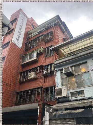
▲更新前建築物立面全貌
