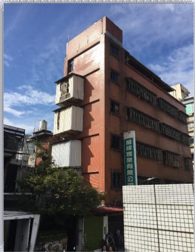
▲更新前建築物立面全貌
