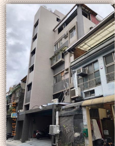
▲更新後建築物立面全貌
