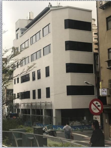
▲更新後建築物立面全貌
